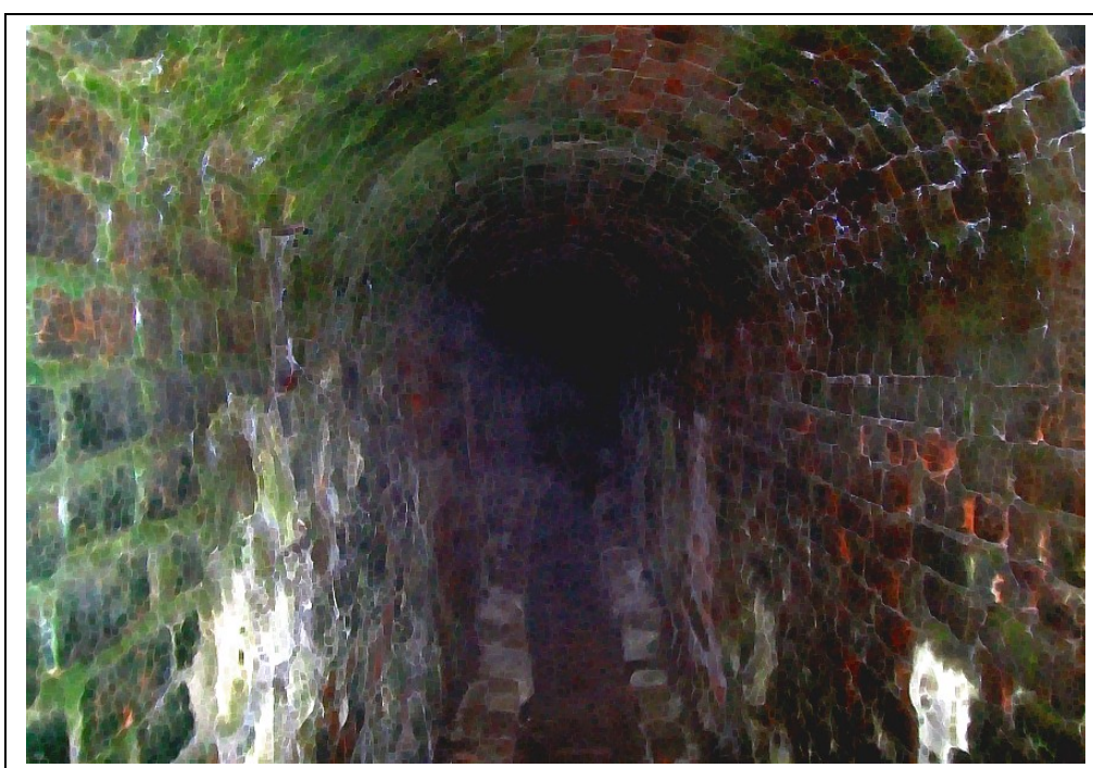
8. Widok wodociągów miejskich. Fot. autor.
