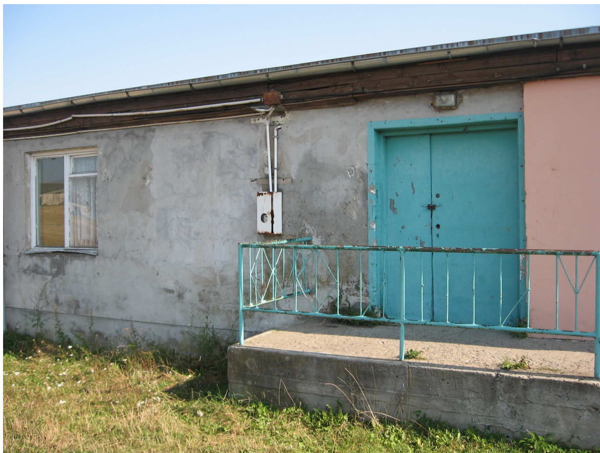
Fotografia nr 1 Świetlica, widok od zewnątrz
